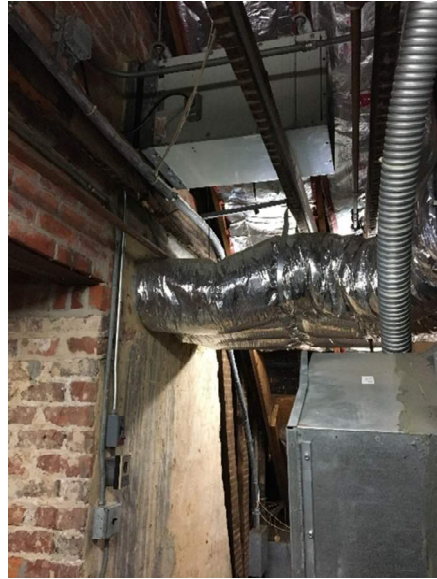
SA ducts entering chimney shaft
